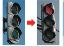
国道337号線の雪付着対策として当別太から川下間の町道17線・19線・24線の3ヶ所の旧型LED信号機をカバー付新型LED信号機へ更新
